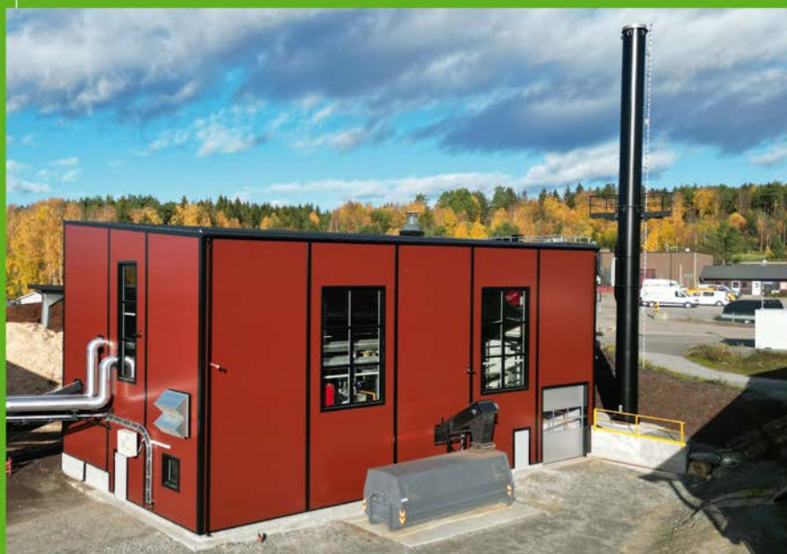
G3 Gran Tre AS, Jaren / NO, Biomassboiler Plant, 4,8 MW, 130 °C
